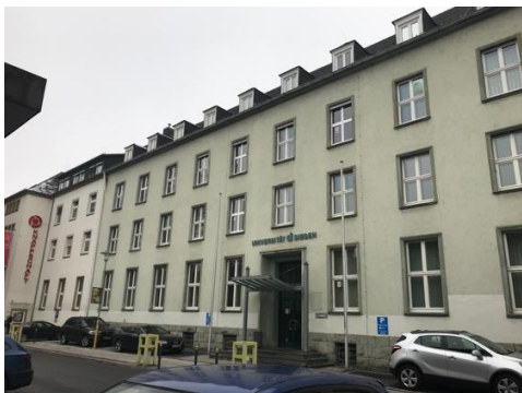
Haupteingang in das Gebäude Herrengarten 3, 2019
