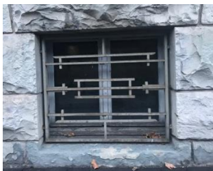
Außenseitiges Gitter eines Kellerfensters, 2019
